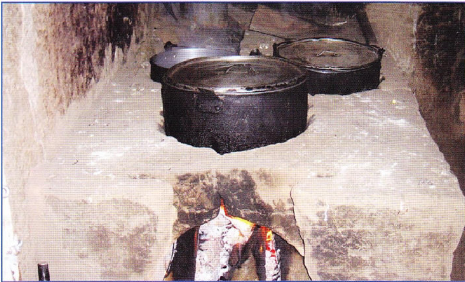
Una de las cocinas de barro construidas en el sector rural por los estudiantes de Arquitectura en pleno funcionamiento dentro de una casa.
